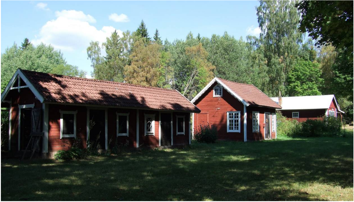
Bod närmast i bild och elverk intill.
